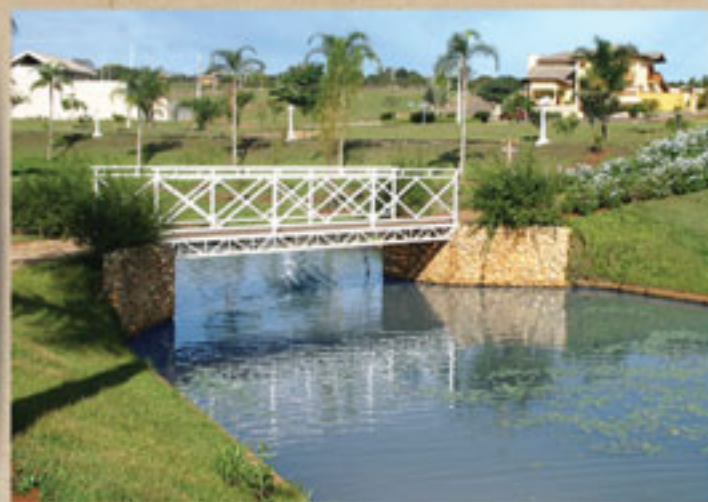
foto ponte no lago
