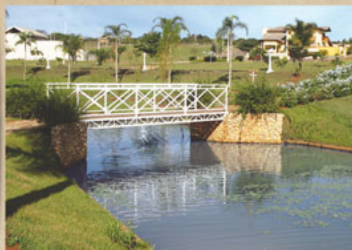
foto ponte no lago
