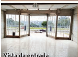
Vista da entrada
