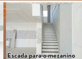
Escada para o mezanino
