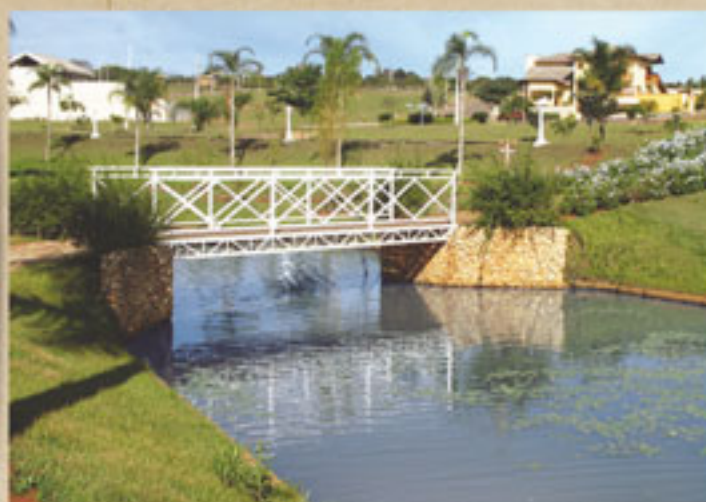
foto ponte no lago
